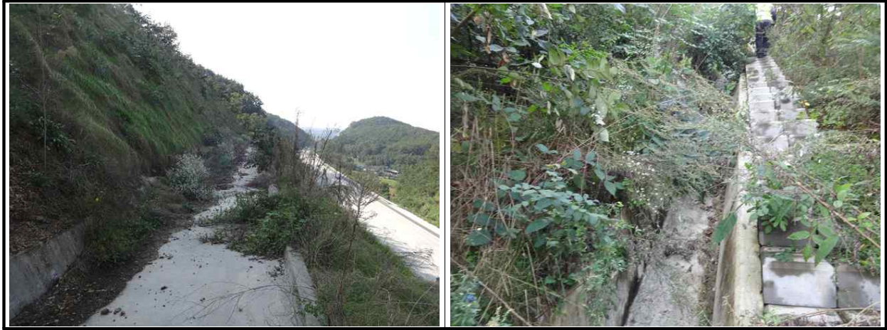
【그림 39.3.3】 배수시설 전경
