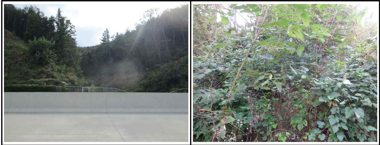
【그림 39.3.1】 상부자연사면 전경
